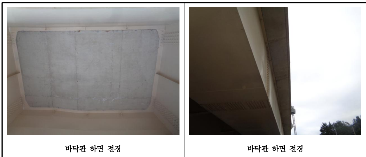
【사진 15.3.23】 바닥판하면 전경
