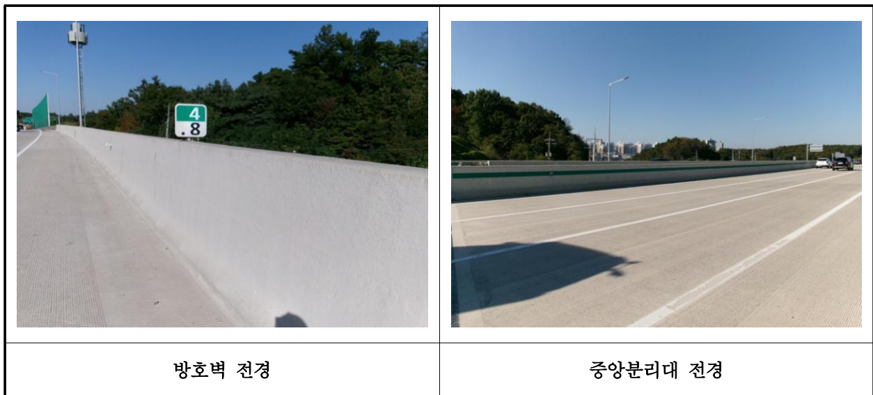
【사진 15.3.42】 방호벽 및 중양분리대 전경
