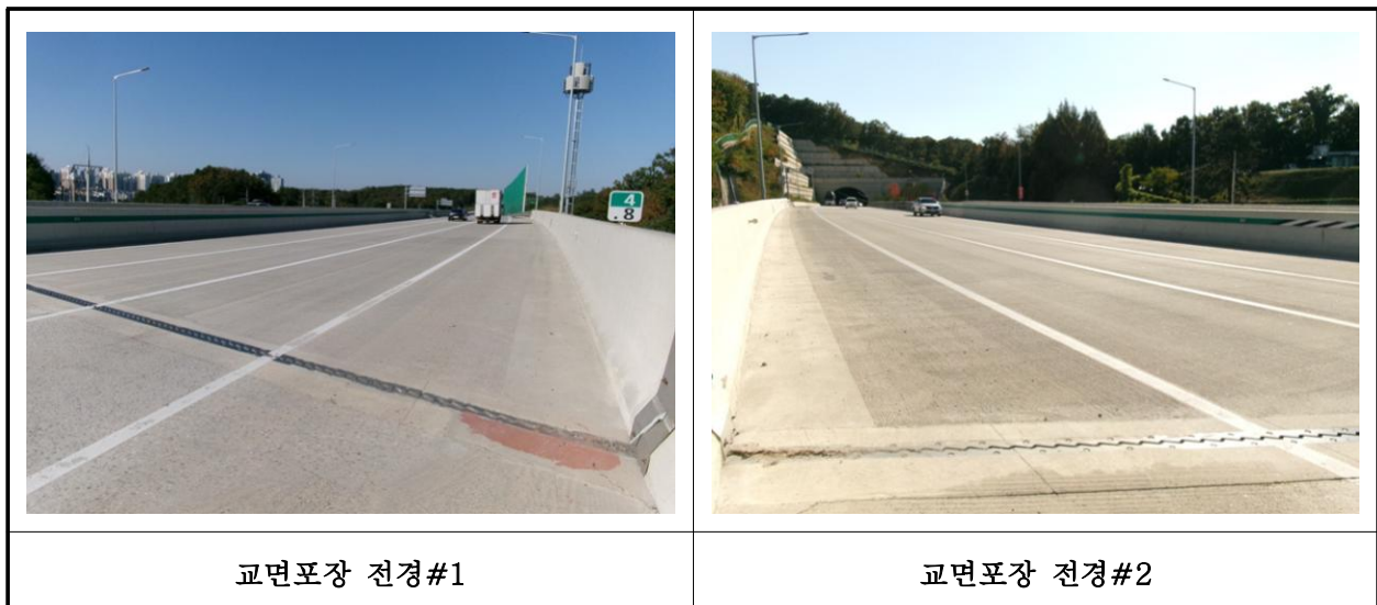
【사진 15.3.38】 교면포장 전경
