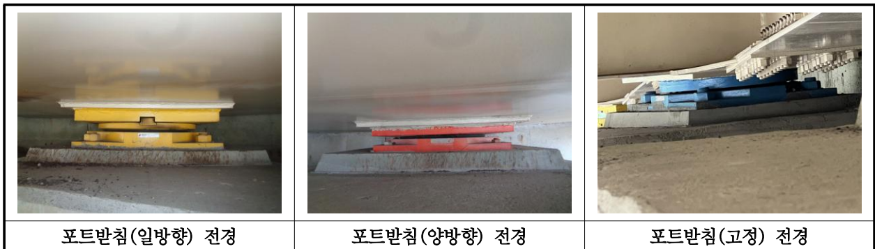
【사진 15.3.10】 교량받침 전경
