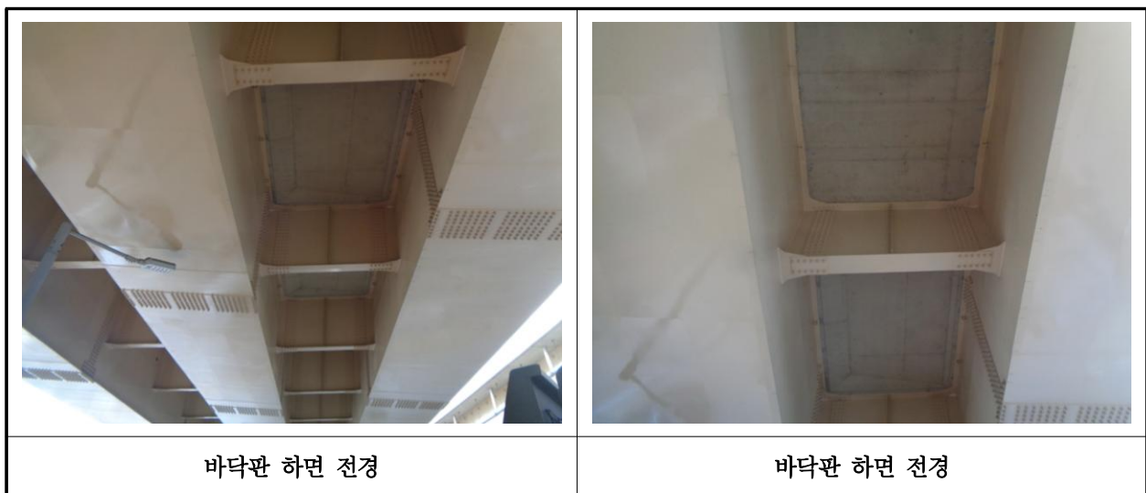
【사진 15.3.2】 바닥판하면 전경
