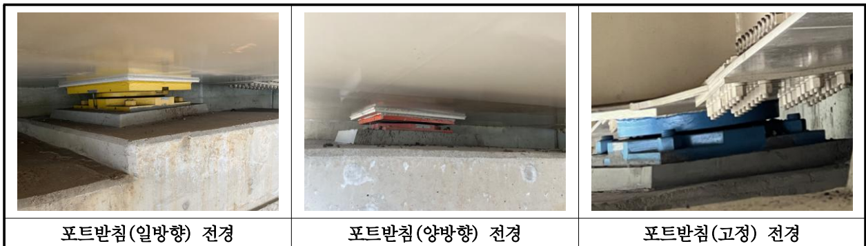
【사진 15.3.31】 교량받침 전경
