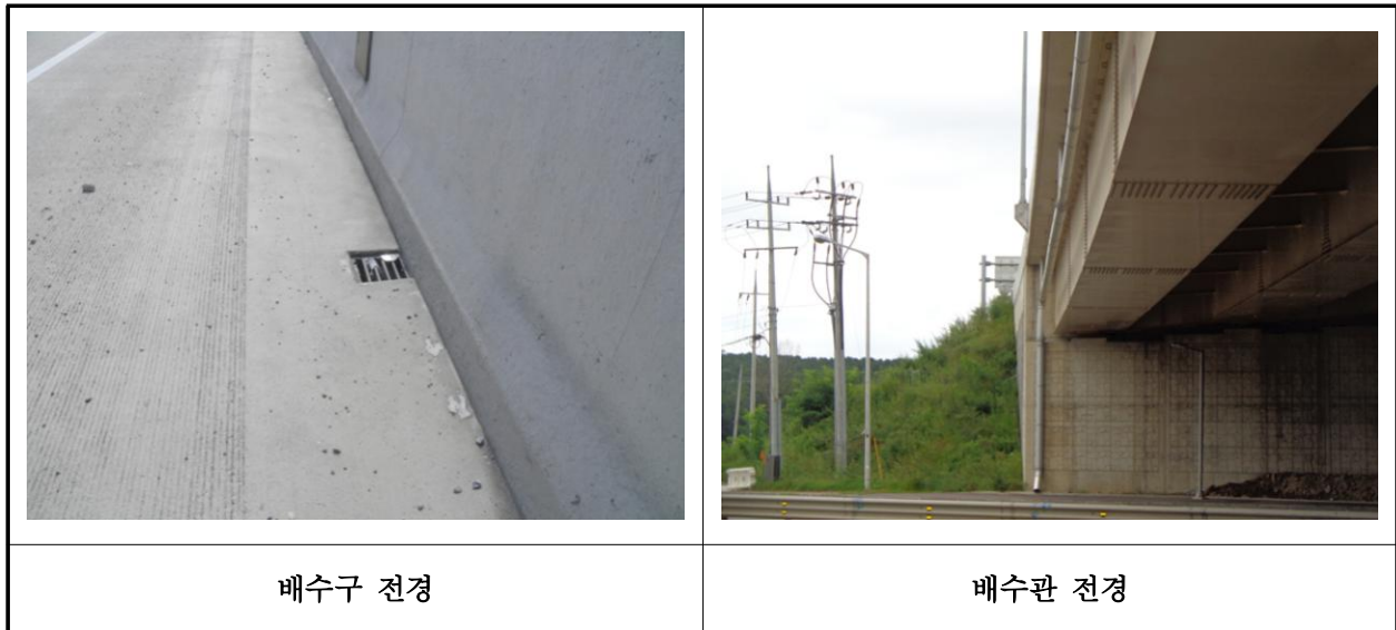
【사진 15.3.19】 배수시설 전경
