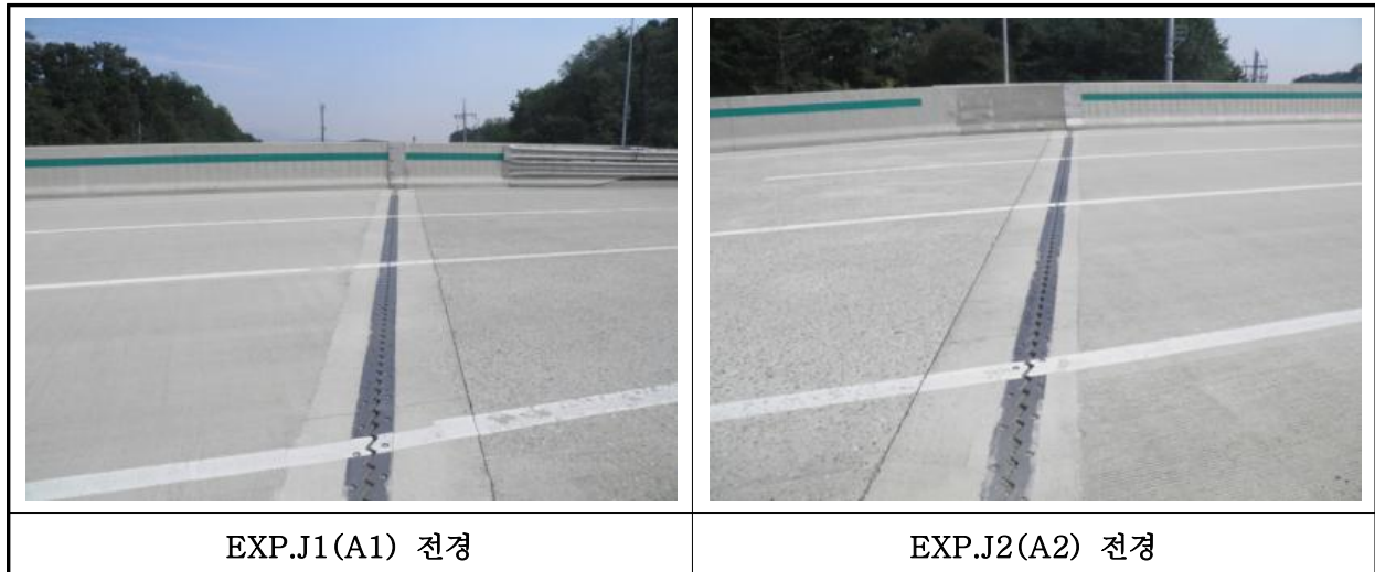
【사진 15.3.14】 신축이음장치 전경
