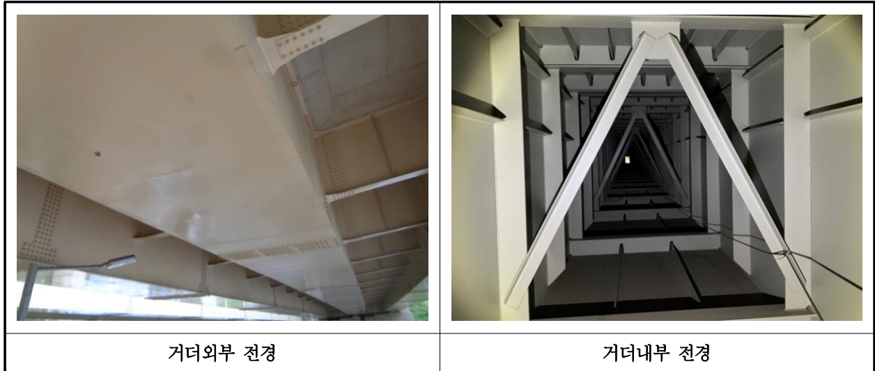
【사진 15.3.25】 거더 전경
