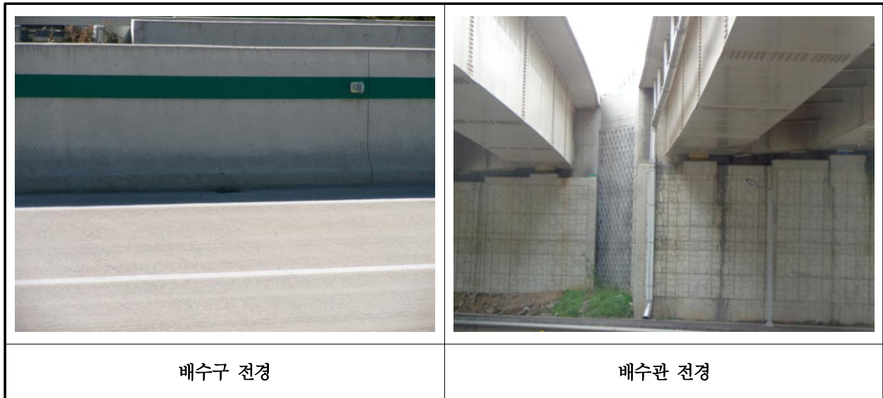
【사진 15.3.40】 배수시설 전경
