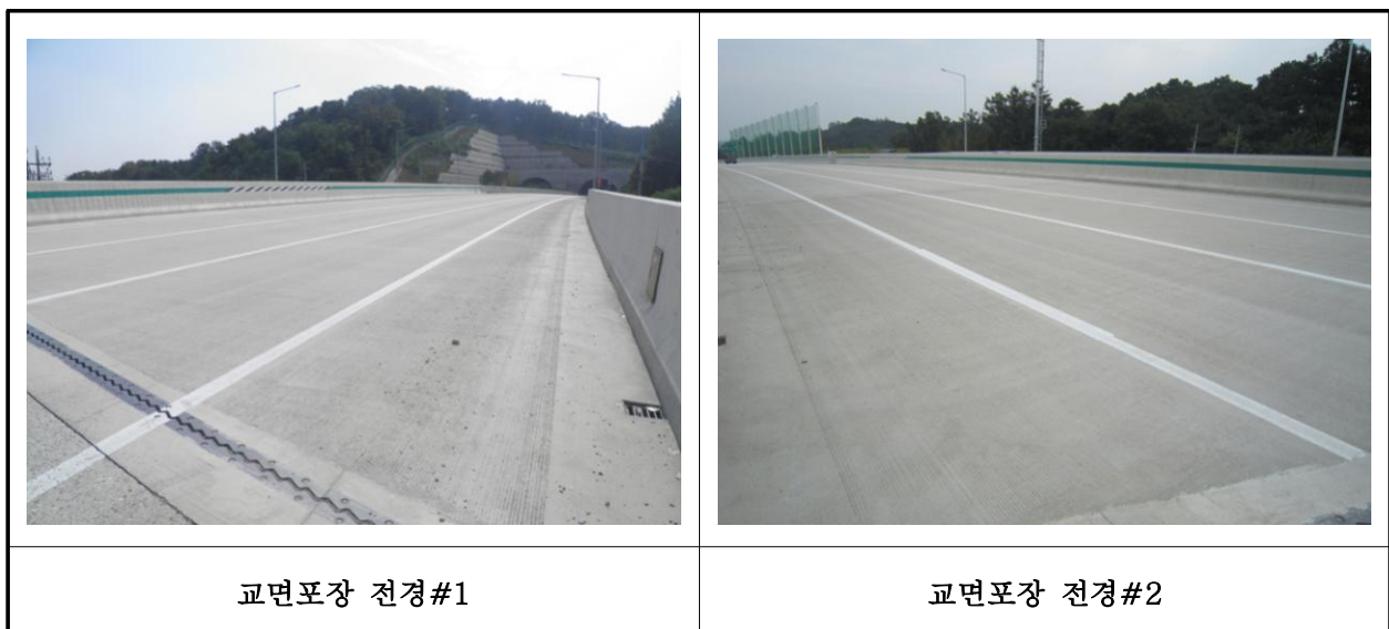
【사진 15.3.17】 교면포장 전경
