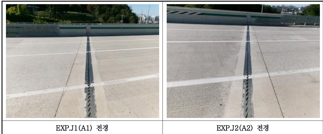
【사진 15.3.35】 신축이음장치 전경
