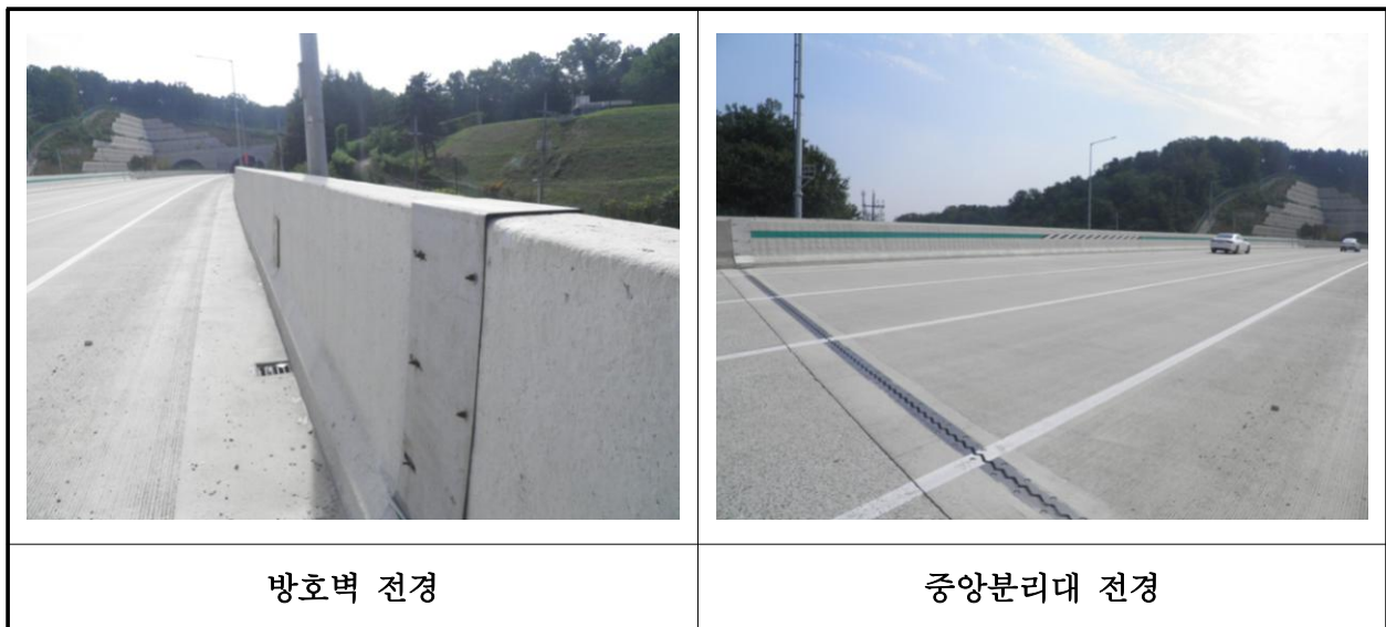
【사진 15.3.21】 방호벽 및 중앙분리대 전경
