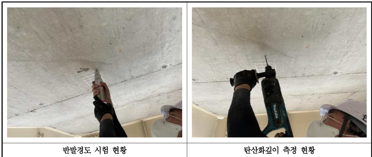
【사진 15.4.1】 콘크리트 내구성조사 현황
