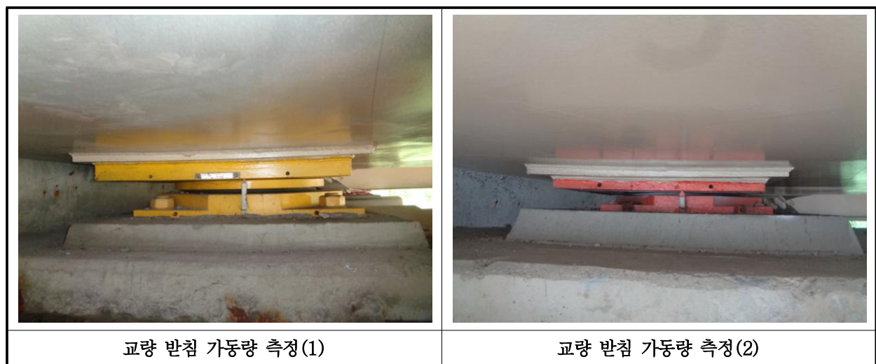
【사진 15.3.13】교량받침 이동량 측정
