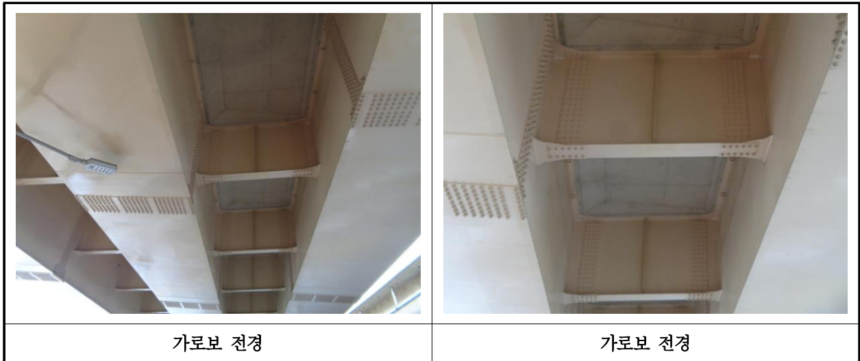
【사진 15.3.6】 가로보 전경
